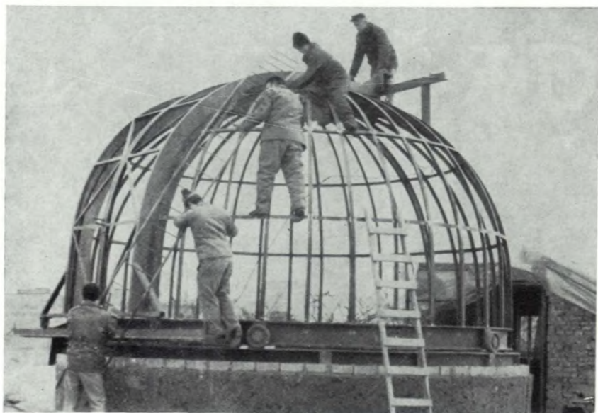
Dve fotografie z montáže astronomickej kopuly na Technickom múzeu v Košiciach (foto A. Korš, k zpráve na str. 102).
